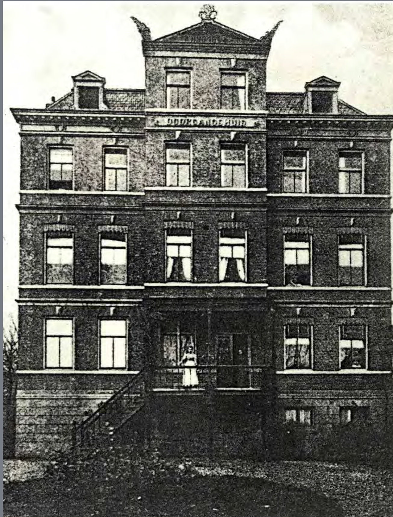
B - "Doorgangshuis der Vereeniging tot redding van, gevallen vrouwen en verlaten kinderen", gebouwd anno 1894
