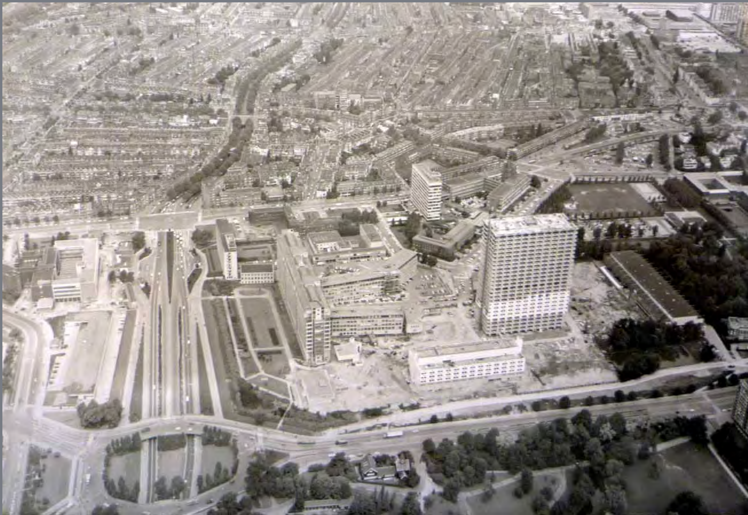
Bouw medische faculteit, luchtfoto vanuit zuiden, 1968
