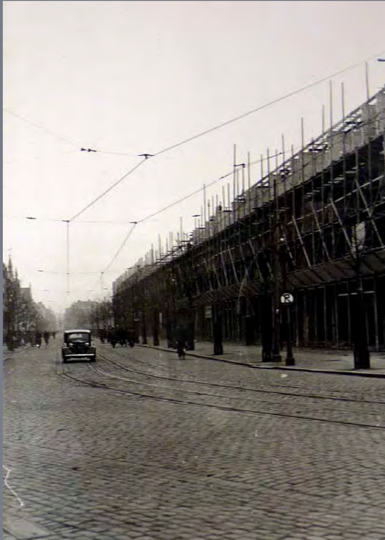
Nieuwe Binnenweg, panden in aanbouw aan, zuidzijde, oktober 1937
